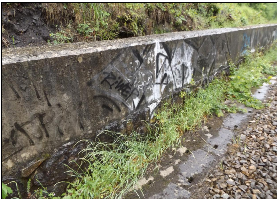
Obr. č. 8 – pohled na úsek zárubní zdi z kamenného zdiva a monolitického betonu zleva
