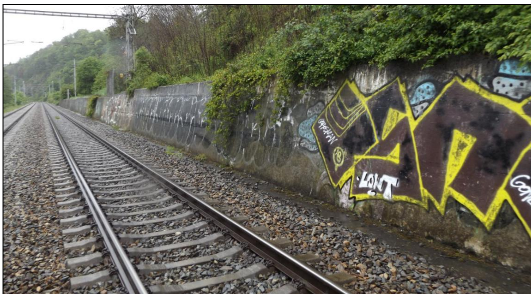
Obr. č. 6 – pohled na úsek zárubní zdi z monolitického betonu zprava
