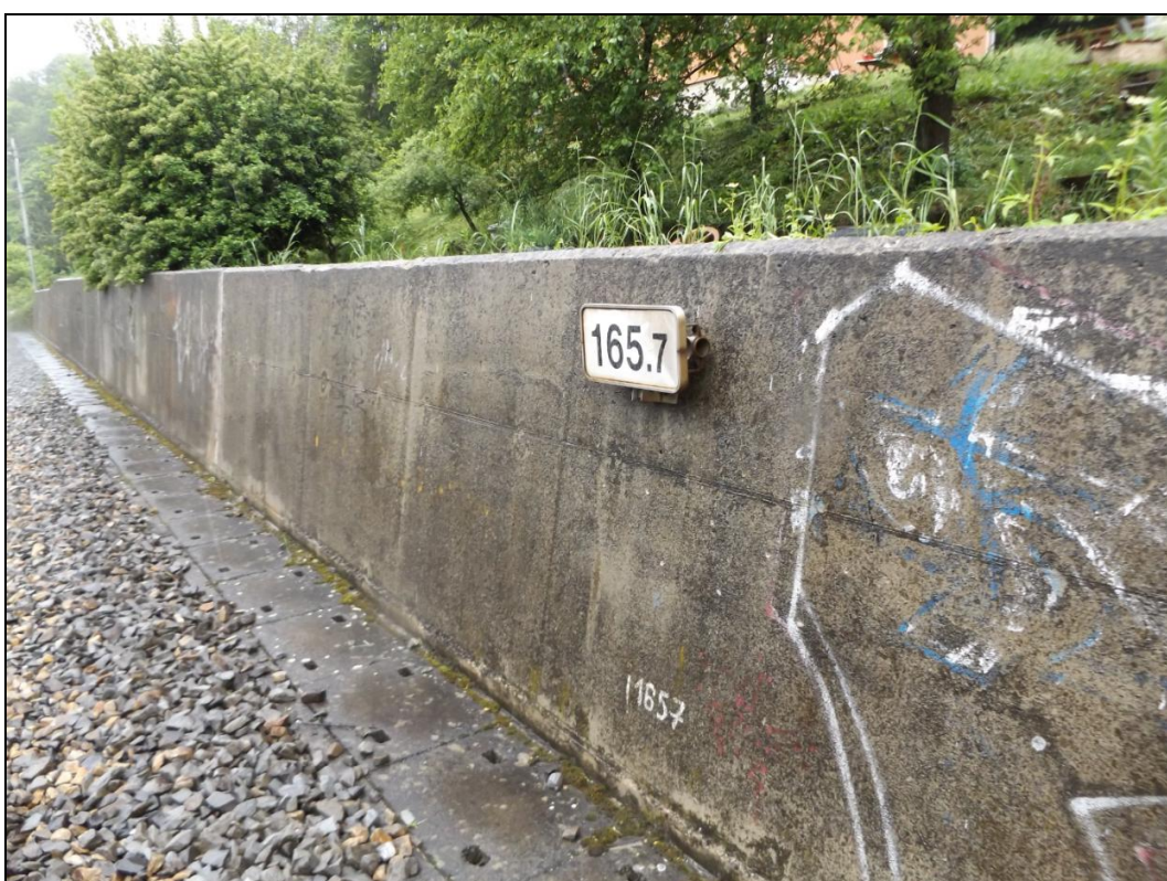
Obr. č. 7 - pohled na úsek zárubní zdi z monolitického betonu zprava
