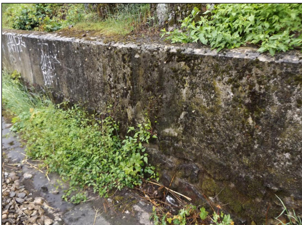
Obr. č. 9 – pohled na úsek zárubní zdi z kamenného zdiva a monolitického betonu zprava
